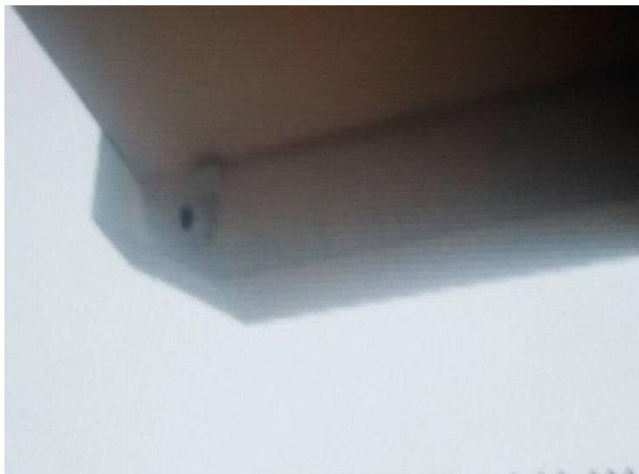
Cámara ubicada correctamente para su funcionamiento
